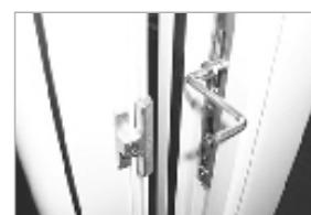
В зависимости от производителя, их внешний вид может различаться, но принцип работы у всех один и тот же. При помощи вращения эксцентриков шестигранником или плоскогубцами можно добиться той степени прижима створки к раме, которая необходима.
