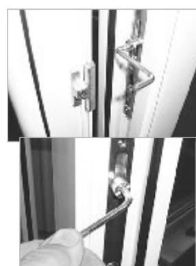
В зависимости от производителя, их внешний вид может различаться, но принцип работы у всех один и тот же. При помощи вращения эксцентриков шестигранником или плоскогубцами можно добиться той степени прижима створки к раме, которая необходима.
