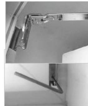
Если оконная створка с поворотно-откидным механизмом, то дополнительно можно отрегулировать прижим регулировочным винтом на ножницах рядом с верхней петлей.
