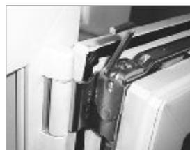
регулировок можно устраниить скос или сдвинуть раму в сторону до 2 мм.
